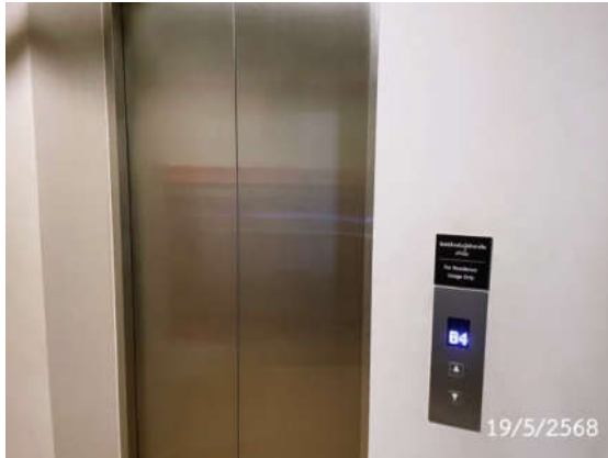
รูปที่ 2-32 ลิฟต์ดับเพลิง
